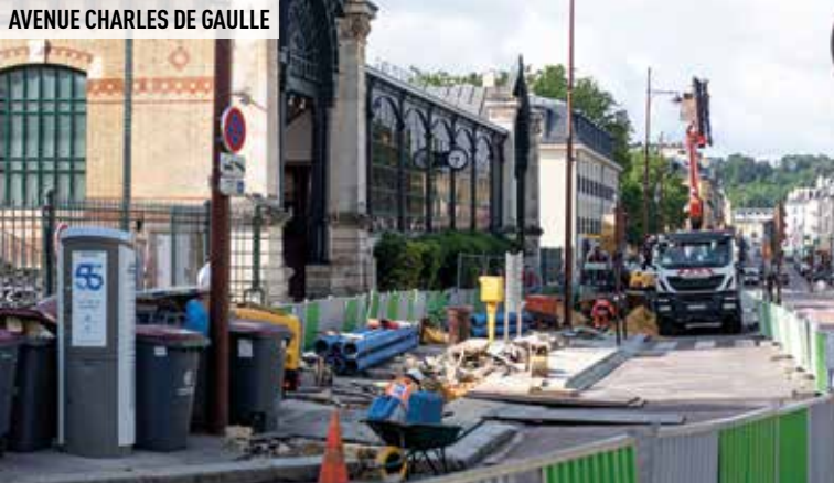
Travaux de remplacement de canalisation d'eau potable.
