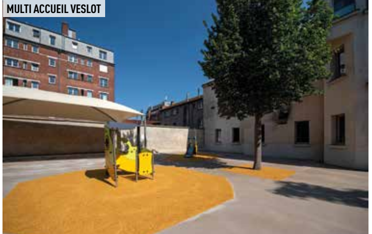
Réaménagement de la cour de la crèche.
