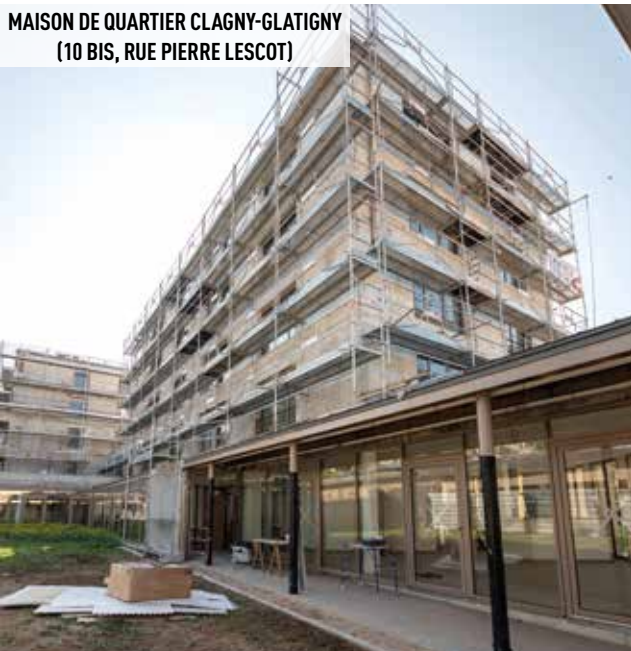
Aménagement intérieur jusqu'au dernier trimestre de cette année.
