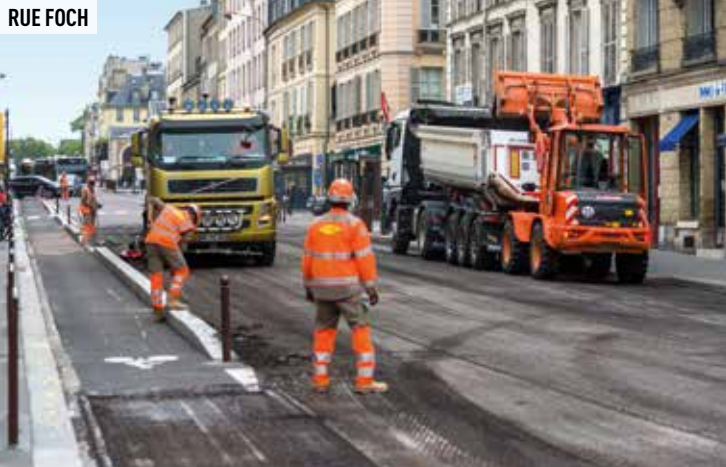
Renouvellement de la couche de roulement de la chaussée.
