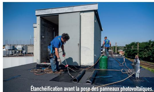
Étanchéification avant la pose des panneaux photovoltaïques.
