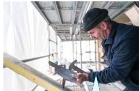
« Nous rénovons, sur un support volige - du bois - l'ensemble de la toiture en ardoises naturelles, avec des clous cuivre. Les ardoises sont taillées à l'ancienne, au marteau ardoise enclume, comme nos ancêtres l'ont fait. Tout est à l'identique. L'ardoise est un matériau vivant : il faut la sentir et savoir l'écouter. »
