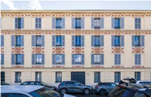
14, rue Jacques Richaud. Prix Maçonnerie 2021.
