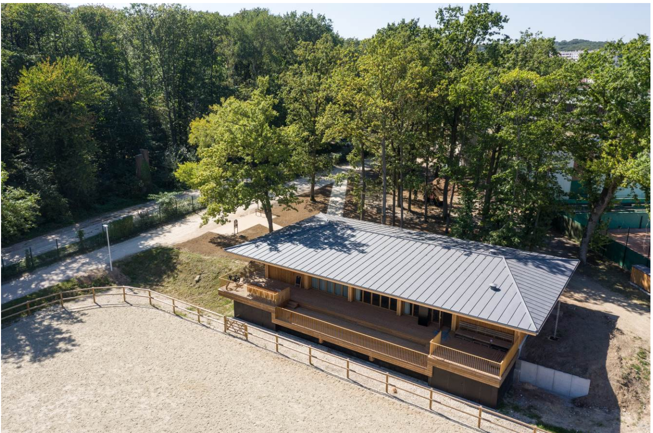
Rénovation du club hippique à Porchefontaine
