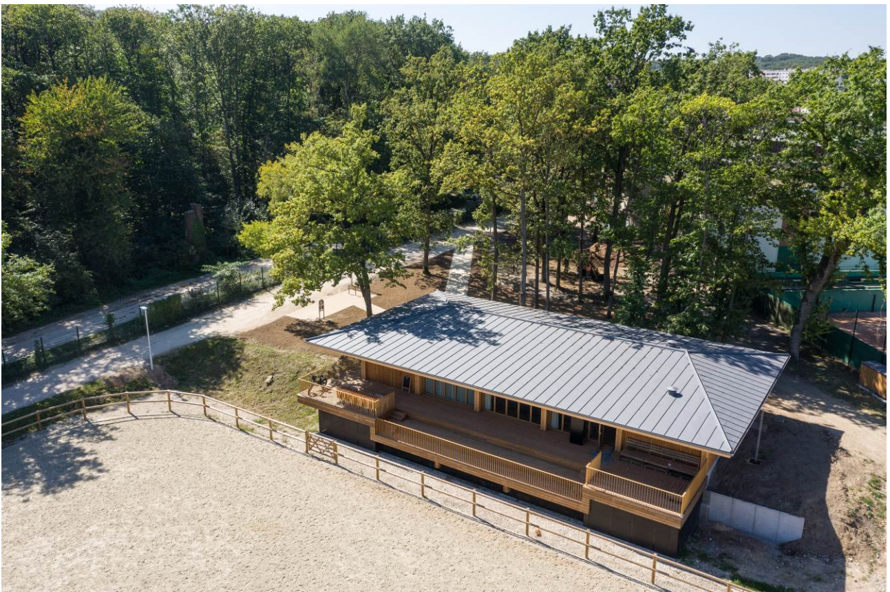
Rénovation du club hippique à Porchefontaine
