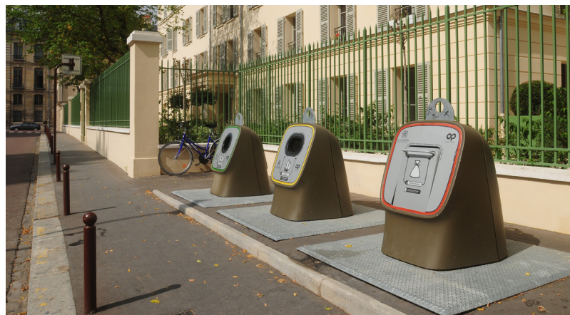
Conteneurs à verre et ordures ménagères
