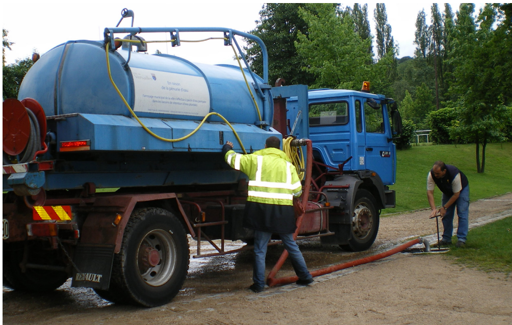
Pompage, stade de Porchefontaine
